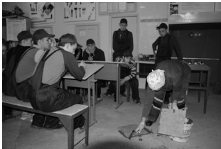
Рисунок 2. Фото практичного показу майстром в/н прийомів настилення підлоги керамічною плиткою.
